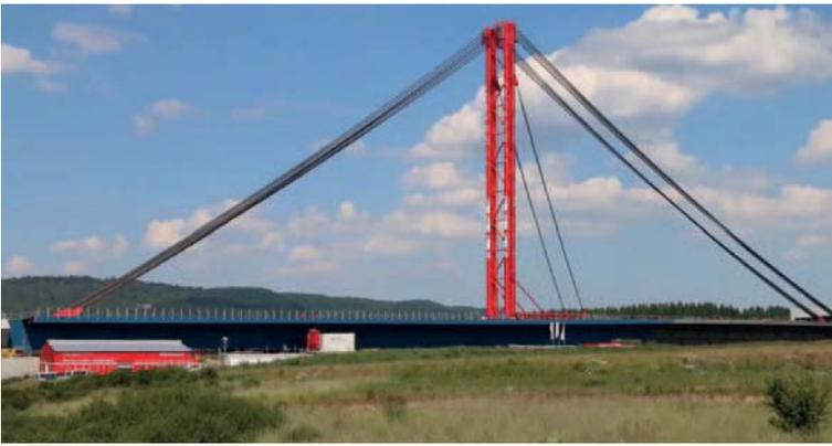
Abb. 25: Pylonsystem, bestehend aus Hauptpylon (stehend) und Hilfsstütze (liegend)
