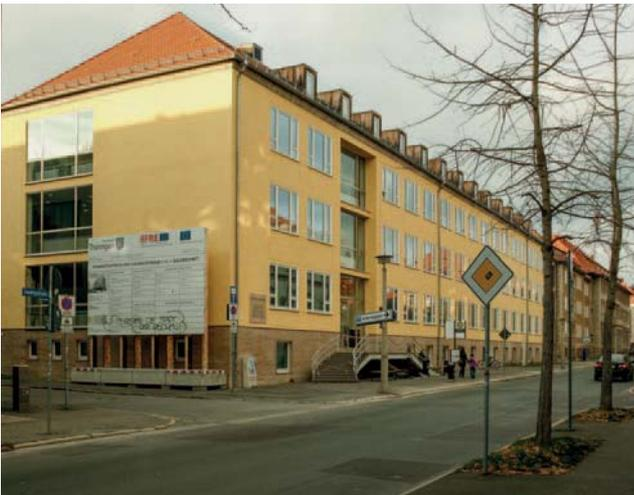
Abb. 6: Für die energetische Sanierung der Bauhaus Universität Weimar wurde ein Aerogel-Hochleistungs-Dämmputz mit Europäischer Technischer Bewertung (ETA) des DIBt verwendet. Aerogel-Dämmputze bestechen durch hervorragende Wärmedämmeigenschaften bei geringem Platzverbrauch.
