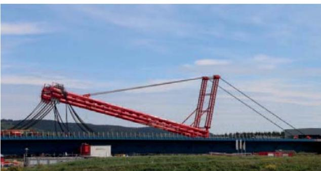
Abb. 29a: Aufrichteprozess des Pylons im Winkel 22,5 Grad
