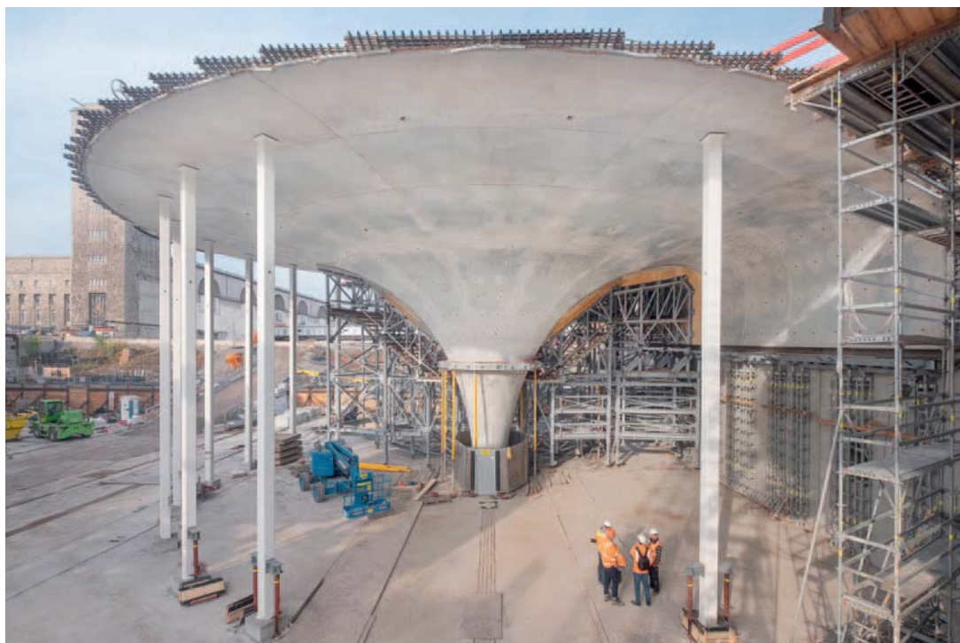
Abb. 11: Temporäre Stützelemente am ausgeschalteten Baukörper
