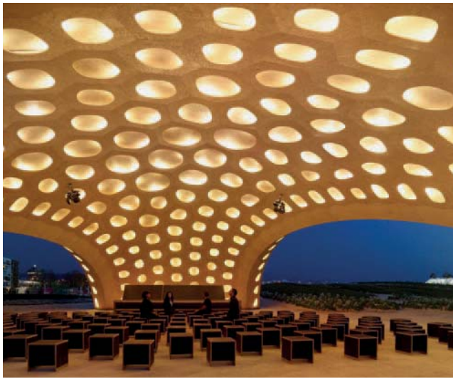
Abb. 2: Ansicht mit indirekt beleuchteten Hohlkassetten von Innen
