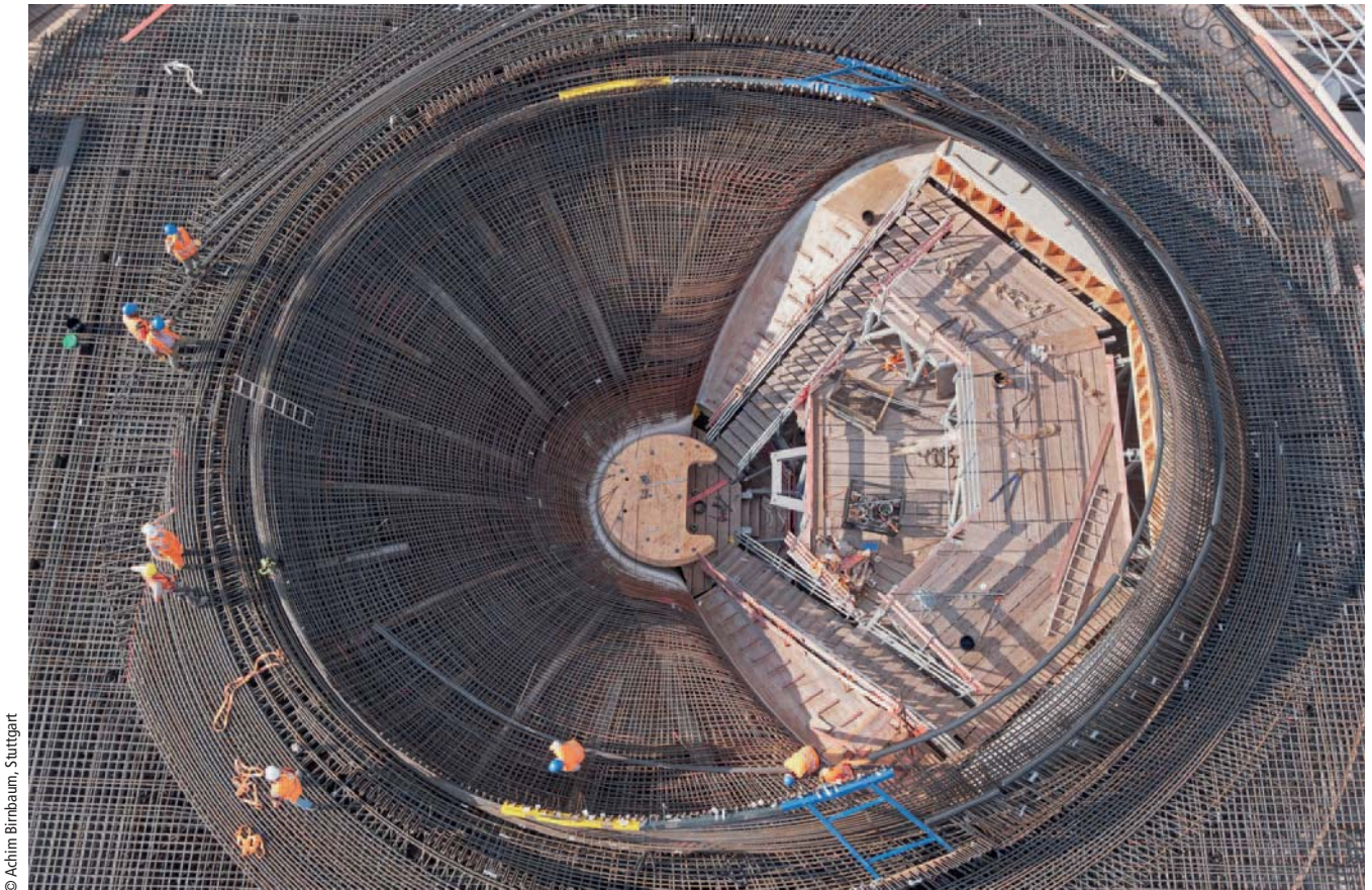
Abb. 8: Aufsicht auf die Bewehrungsarbeiten an einem Regelkelch
