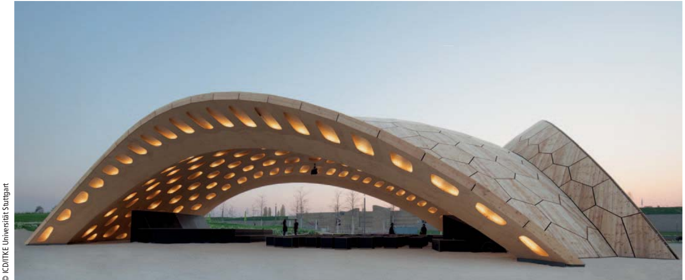
Abb. 1: Der Holzpavillon auf der Bundesgartenschau in Heilbronn mit seiner Spannweite von fast 30 Meter
