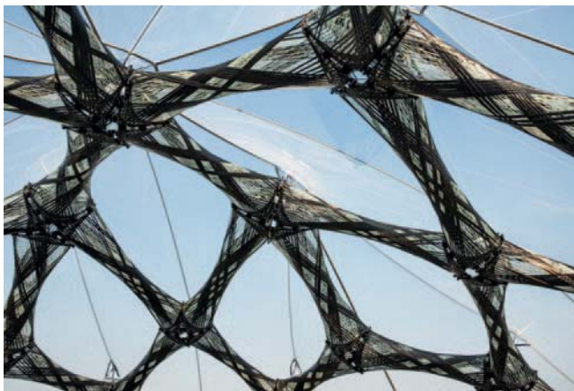
Abb. 8: Innenansicht der tragenden Faserverbundstruktur
