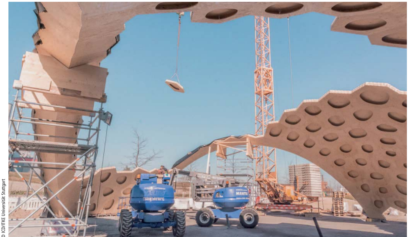
Abb. 5: Freier Vorbau des Schalentragswerks
