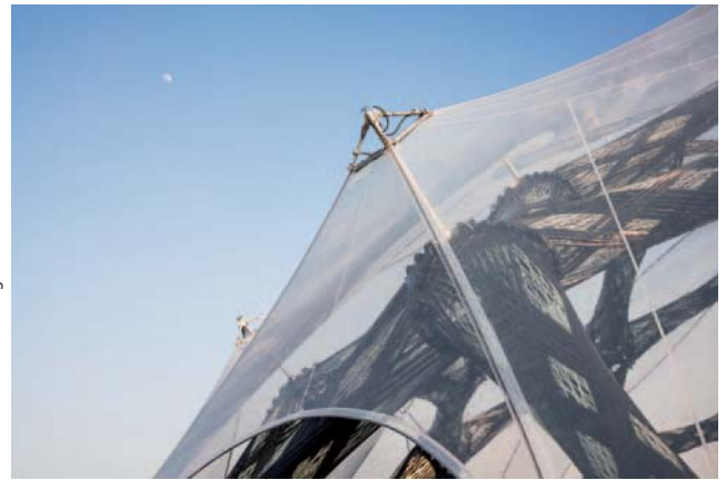
Abb. 12: Überspannung mit ETFE Folie
