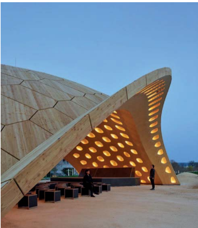
Abb. 6: Randbalken des BUGA-Holzpavillons
