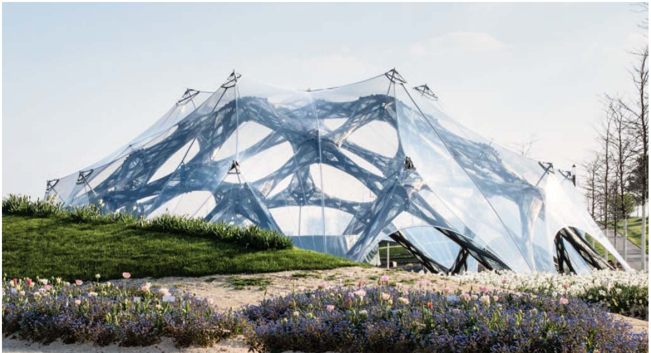
Abb. 7: Der BUGA-Faserpavillon mit einer Spannweite von 23 Meter
