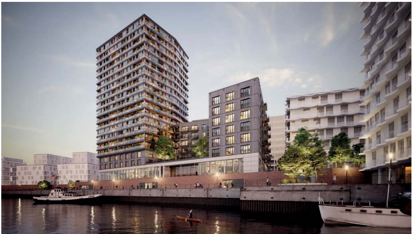
Abb. 2: Hochhäuser in Holzbauweise sind schon lange kein Tabu mehr, wie auch dieses derzeit in Hamburgs HafenCity im Bau befindliche Hochhaus („Roots“) mit seinem angrenzendem Riegelgebäude in Massivholzbauweise mit überwiegender Wohnnutzung beweist (Bauherr: Garbe Immobilien-Projekte GmbH, Architekten: Störmer Murphy and Partners (Hamburg)).
