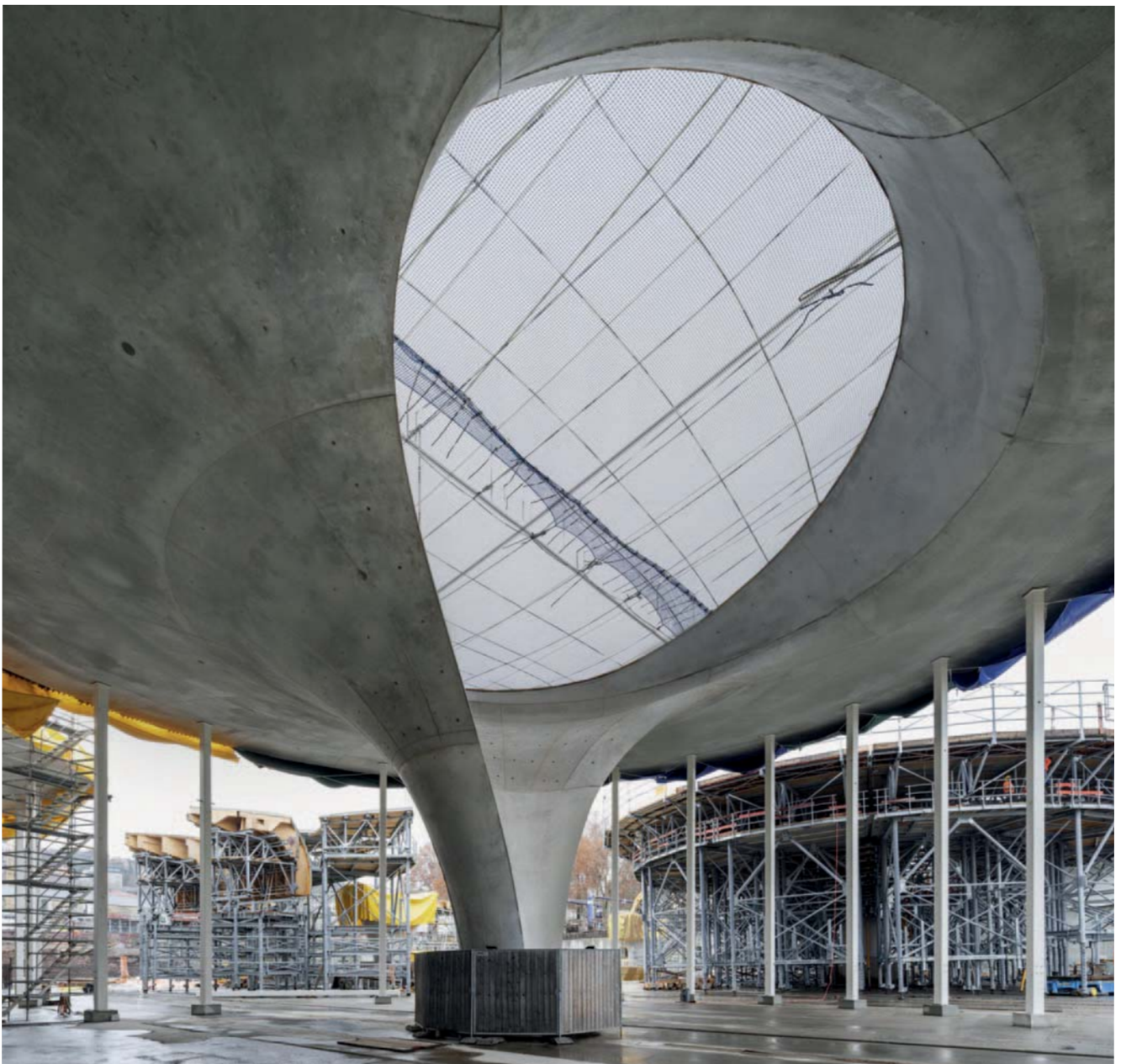
Abb. 10: Blick in das Lichtauge einer Kelchstütze
