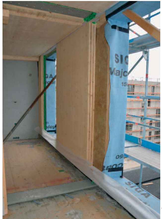
Abb. 12: Ein Holzrahmen-Element mit Dämmung im eingebauten Zustand
