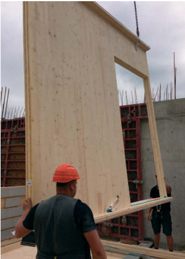
Abb. 11: Ein Holzrahmen-Element ohne Dämmung und ohne geschlossene Seiten wird eingehoben.
