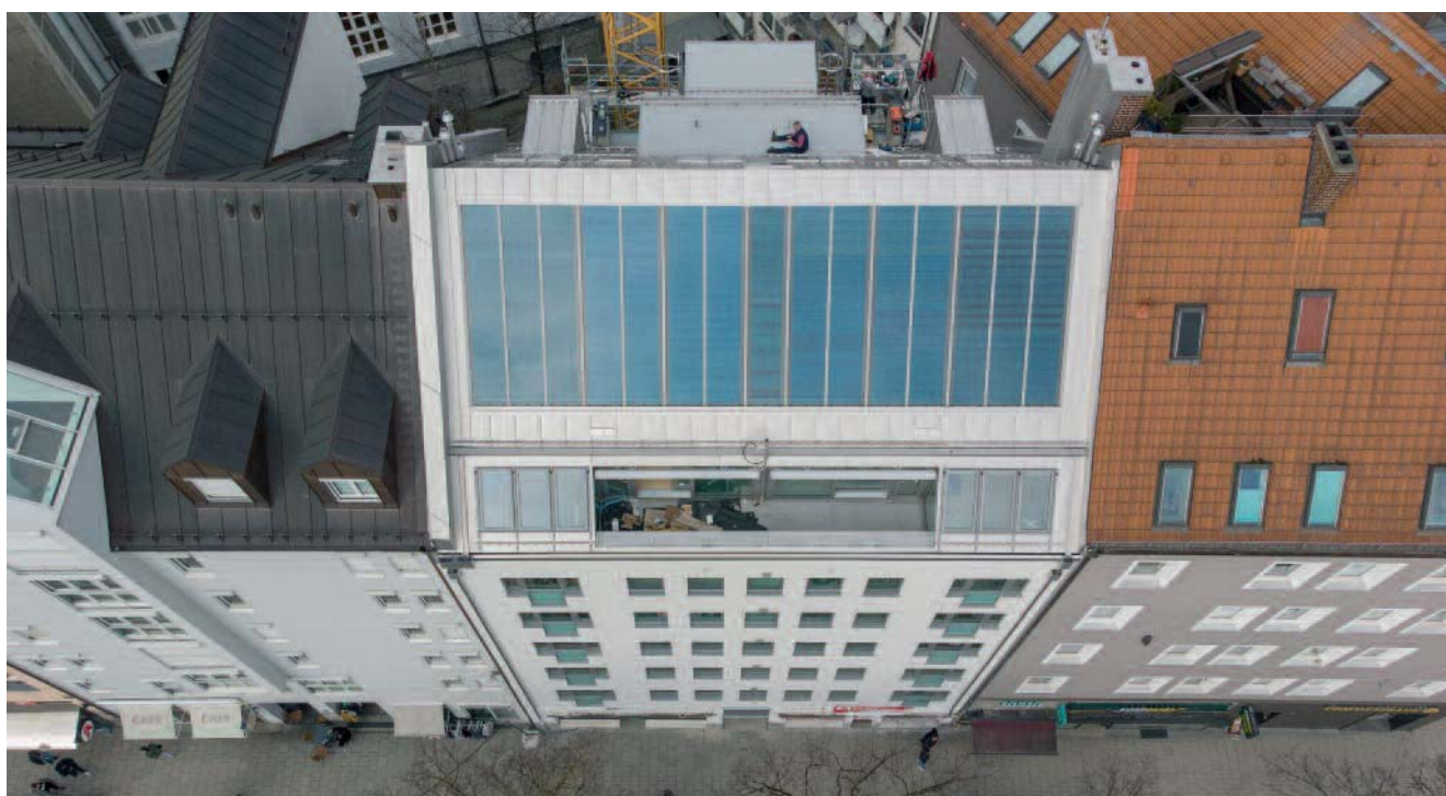
Abb. 4: Zweigeschossige Aufstockung in Brettsperrholzbauweise am Tegernseer Platz in München
