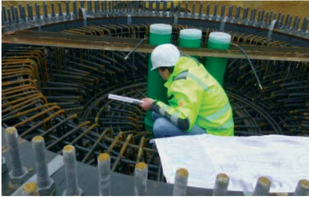
Abb. 7: Kontrollen der Bauausführung für das Fundament
