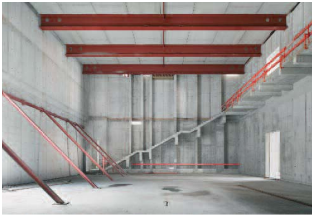
Abb. 17: Verbundkonstruktion der Kuben K1 und K2
