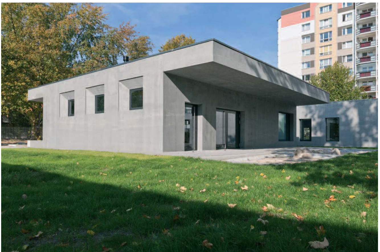
Abb. 7: Bauvorhaben Jugendfreizeiteinrichtung „Betonoase“
