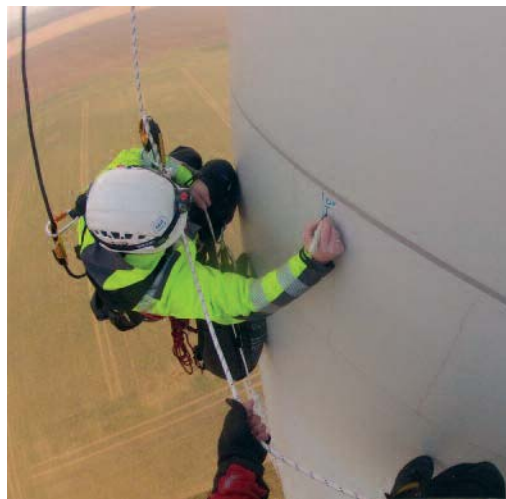
Abb. 8: Turmprüfung mit Hilfe der Seilzugangstechnik (SZT)
