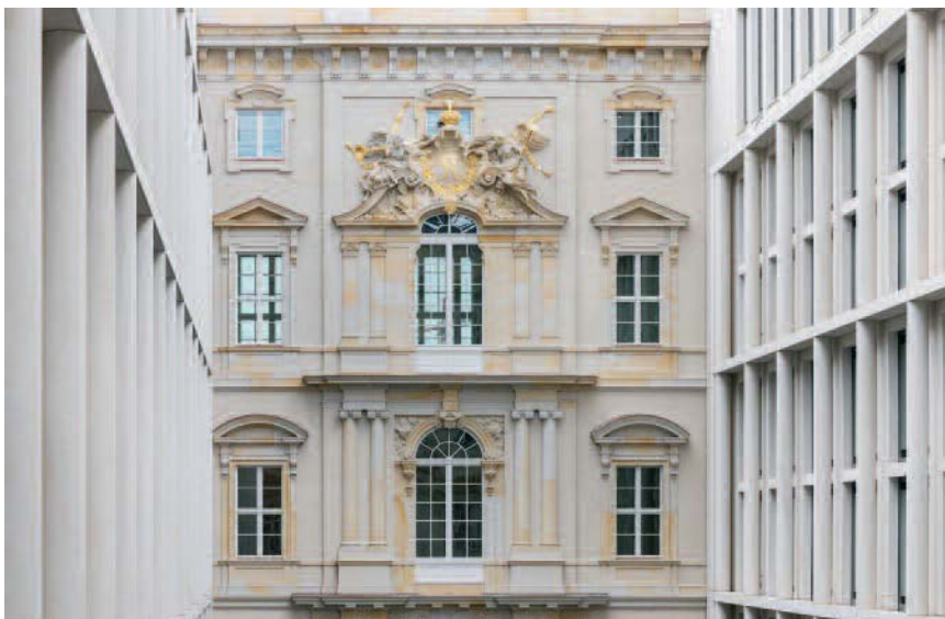
Abb. 21: Neubaufassade im Schlossforum und Rekonstruktion der Schlossplatzportale
