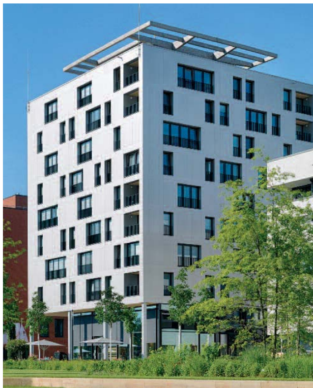
Abb. 3: Skaio Heilbronn, das erste deutsche Hochhaus aus Holz: zehn Geschosse im Skelettbau, Sockelgeschoss und Treppenhaukern aus Stahlbeton, Wände und Decken aus Holz
