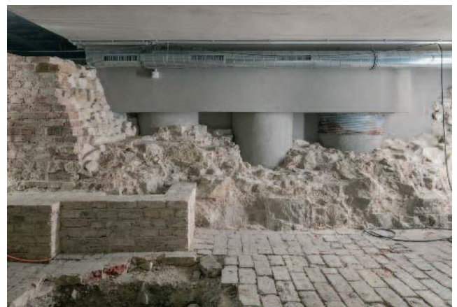
Abb. 13a und b: Reste des Bestandsmauerwerks vor (oben) und nach dem Einbringen der Tiefgründung
