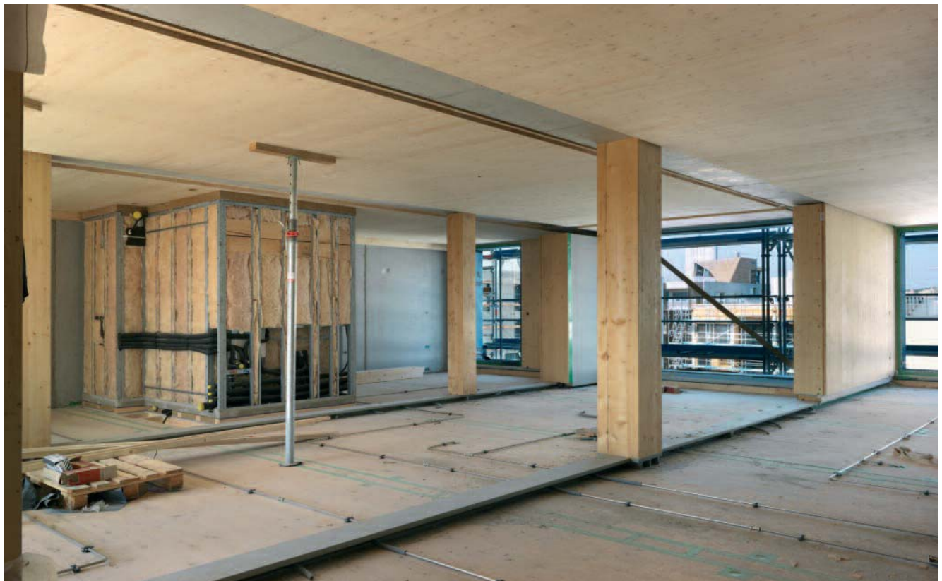
Abb. 10: Stützelagerter Stahlunterzug im Übergangsbereich vom Zehn- zum Sechsgeschosser
