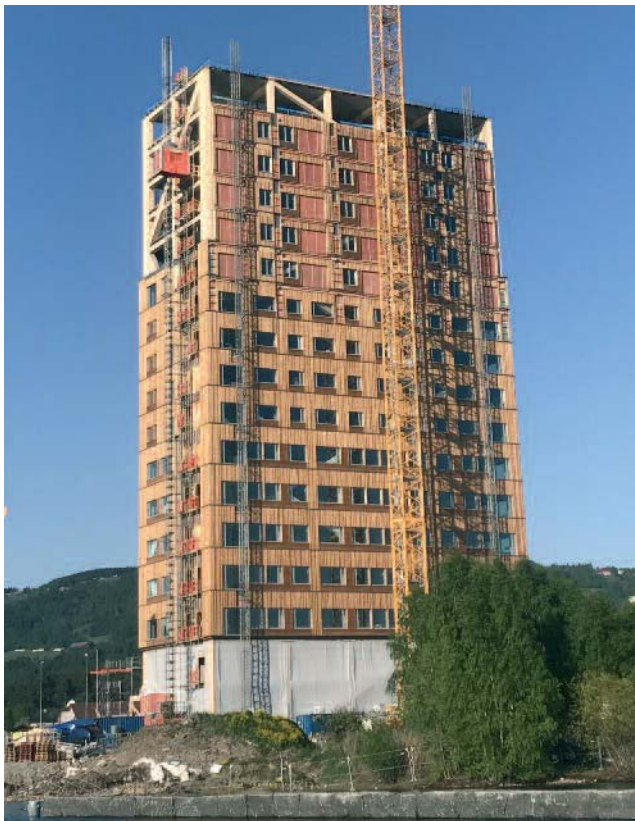
Abb. 2: Das zeitweise höchste Holzgebäude der Welt (Mjøstårnet) in Norwegen. Es wird durch ein außenliegendes Fachwerk ausgesteift, die Aufzugsschächte und Treppenträume sind aus Brettsperrholz, die mit einer nichtbrennbaren Bekleidung ummantelt wurden.
