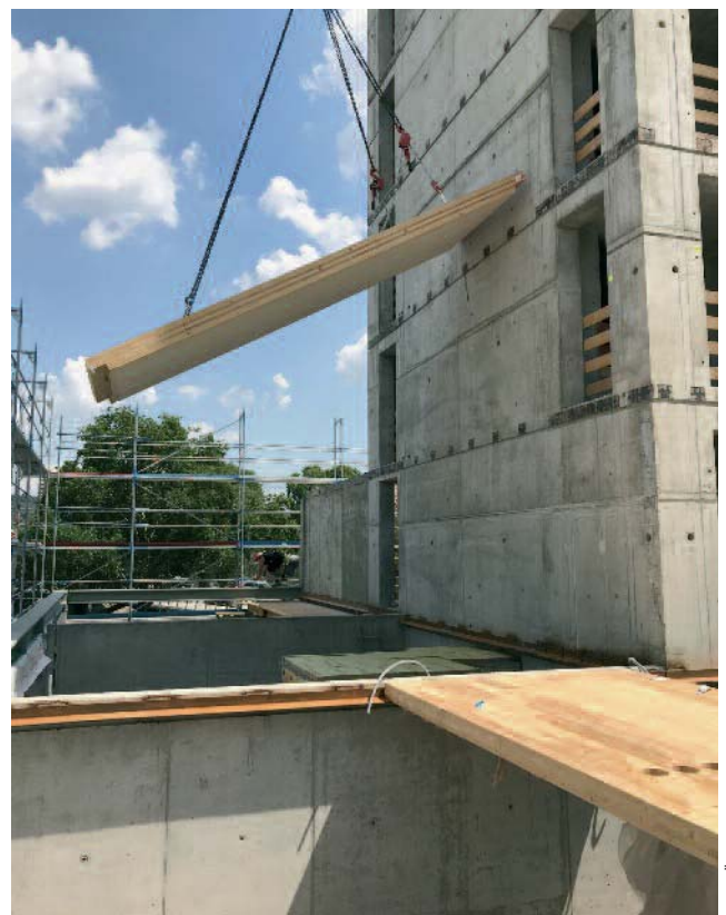
Abb. 8: Die BSP-Decken-Elemente spannen von den Stahlträgern in der Außenwandebene zum Treppenhaukern. Zwischenaufleger (hier aus Stahlbeton) ermöglichen den Spannrichtungswechsel.
