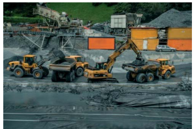
Abb. 7b: Materiallogistik bei der Aufbereitungsanlage
