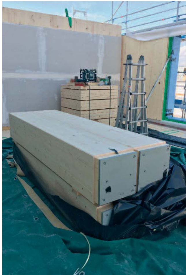
Abb. 17: Die quadratischen BSH-Stützen mit Lastverteilungsplatten an Fuß und Kopf liegen zur Montage bereit.
