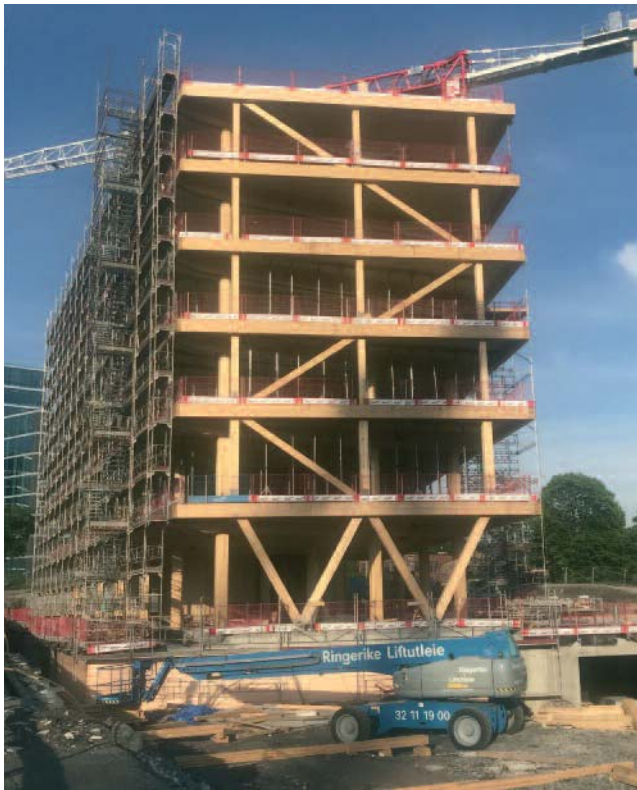
Abb.: 5: Bürogebäude in Oslo (2019, im Bau): stabförmige Bauelemente für Stützen und Träger und großflächige Elemente für Wände und Decken
