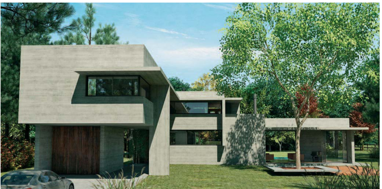
Abb. 10: Landhaus aus Infraleichtbeton (Architekten: Besonias Almeida Arquitectos (Buenos Aires)) (siehe auch Abb. 11)
