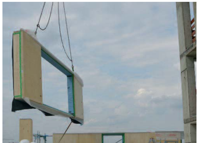
Abb. 6: Ein vorgefertigtes Außenwandelement mit großem Fenster und geschlossenen Seiten wird zwischen die Stützen eingefügt.
