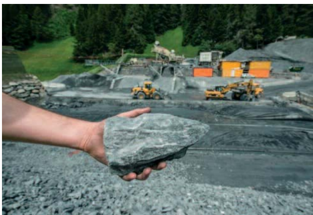
Abb. 7a: Tunnelausbruch – gebrochen auf 30/150 Millimeter
