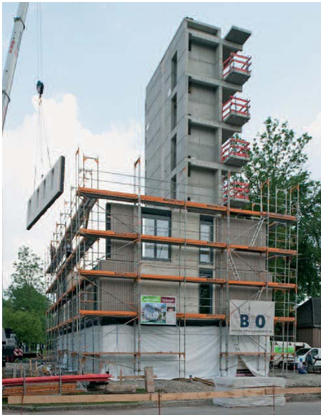
Abb. 1: Das erste achtgeschossige Gebäude in Holzbauweise (H8) in Bad Aibling. Es wird von einem Stahlbeton-Treppenturm aus Fertigteilen ausgesteift, seine Wände und Decken sind aus massivem Holz.
