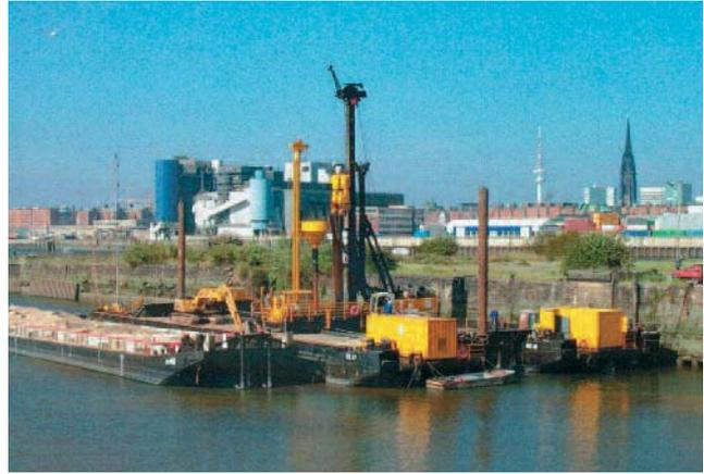
Abb. 4: In diesem Segelschiffhafen hat die Fa. Möbius den Einsatz der GEC-Säulen auch Unterwasser erfolgreich getestet. Damit konnte der Sondervorschlag eingereicht werden.
