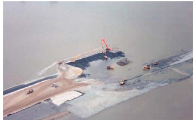
Abb. 12: Auf die horizontale Bewehrung wurden am Deichfuß Spüldeiche aufgesetzt, die Bestandteil des endgültigen Deckwerkes wurden.
