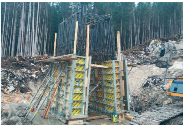
Abb. 15: Schalung und Bewehrung eines Stützenfußsockels
