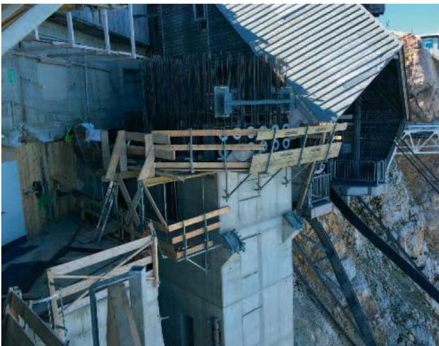
Abb. 21: Einbauteile und Spanngliedverankerung Schacht West
