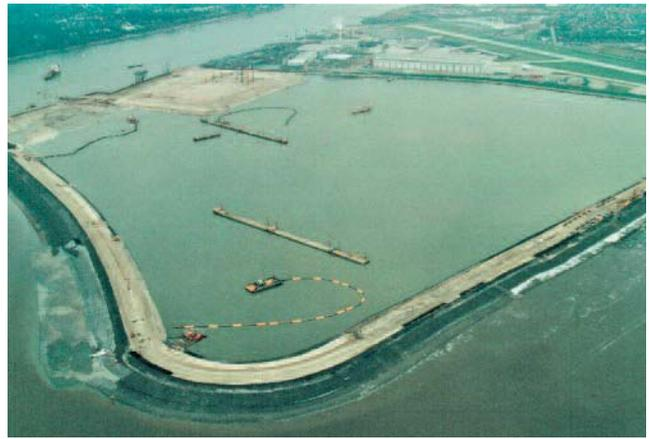
Abb. 15: In der Fläche der hier deutlich erkennbaren aufgehöhten Sektionsbaufläche sind die Führungspontons für die Verrieselungsgeräte zu sehen.
