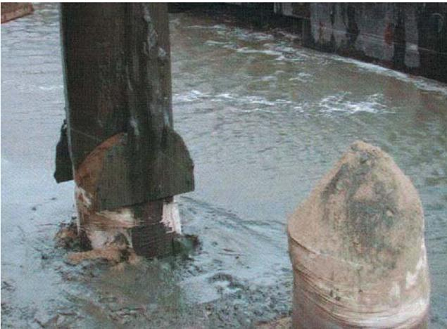
Abb. 10: Für die Arbeiten im Mühlenberger Loch wurde ein Verdrängungsrohr mit speziell von der Fa. Möbius entwickelten hydraulischen Klappen verwendet. Dieses Rohr wurde durch die Weichschichten in den tragenden Untergrund gerüttelt, wo sich die Klappen öffneten und gleichzeitig das Rohr unter Rüttelwirkung gezogen wurde.
