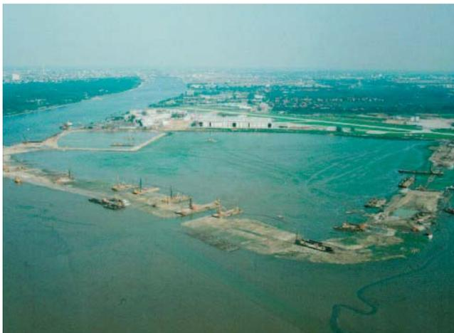
Abb. 7: Die entstehende neue Industriefläche im Mühlenberger Loch nach erheblichem Baufortschritt. Im Norden ist die Hochwasserschutzwand erkennbar, davor die Sektionsbaufläche.
