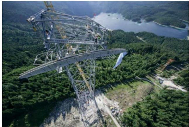
Abb. 16: Neue Streckenstütze im Montagezustand
