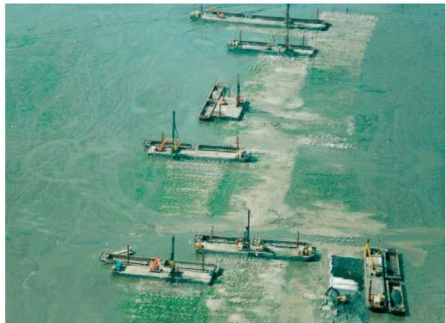
Abb. 8: Die Mäklengeräte konnten von den achtzehn schwimmenden Pontoneinheiten aus mit entsprechenden Auslegern bis zu fünf Säulenreihen von einer Pontonposition aus erstellen.
