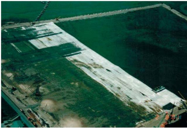
Abb. 14: Die Sektionsbaufläche erforderte einen schnellen Baufortschritt und wurde deshalb mit einem Polderdamm umschlossen, der sich auf 6.000 GEC-Säulen gründete.
