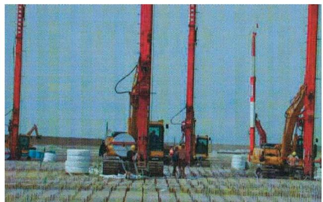
Abb. 18: Einbau der Vertikaldrains
