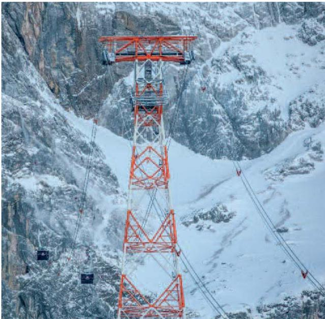
Abb. 13: Stahlfachwerk der Gittermaststütze
