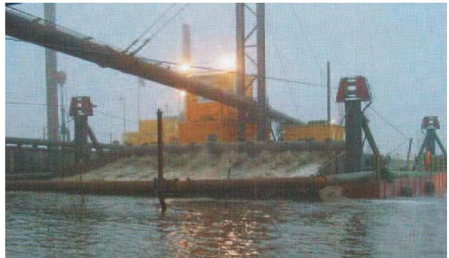
Abb. 16: Zwecks sehr präziser Verrieselung wurden mehrere Pontons zum einem „Lineal“ gekoppelt, an dem das Verrieselungsgerät geführt wurde.
