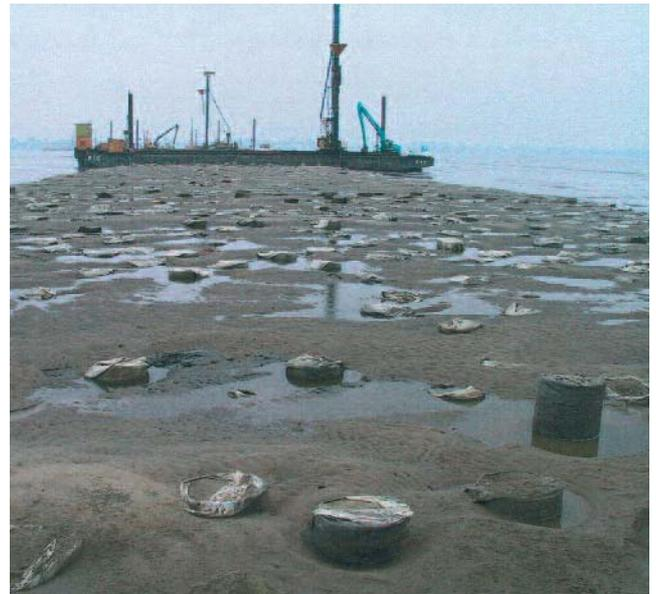
Abb. 11: Nach mehrfacher Überflutung der Säulenköpfe stellte sich heraus, dass sich der Bereich zwischen den Säulen relativ erosionsstabil einstellt.
