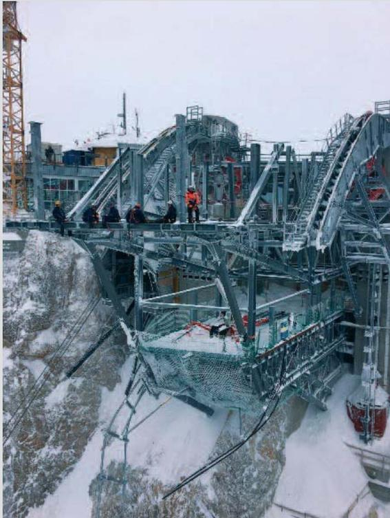
*GERÜSTBAU UNTER HÄRTESTEN BEDINGUNGEN war für den Bau der neuen Zugspitz-Seilbahn nötig, die das längste freie Spannfeld und den größten Gesamthöhendifferenz der Welt überwindet. Wir schildern die sehr schwierigen geologischen Gründungsverhältnisse für die neue Berg- und Talstation der Zugspitz-Seilbahn und beschreiben ihre Tragsysteme und die faszinierende Seilbahntechnik, und zwar ab ..... Seite 18*
