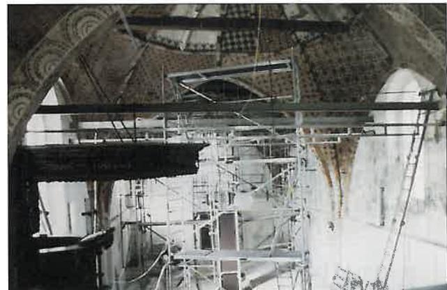
Abb. 28: Kreuzrippengewölbe mit Zugstangen
