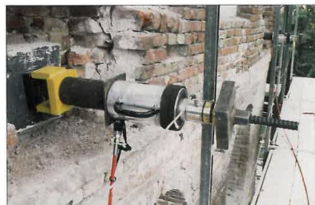
Abb. 29: Hydraulische Pressen und Verschiebungsmessung zur Steuerung der Vorspannkkräfte
