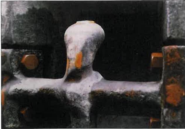
Abb. 24: Geschraubtes Haltekreuz mit Zapfenantrieb
