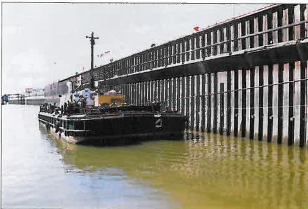
Abb. 30: Ansicht gegen die Spundwand mit Arbeitsschiff
