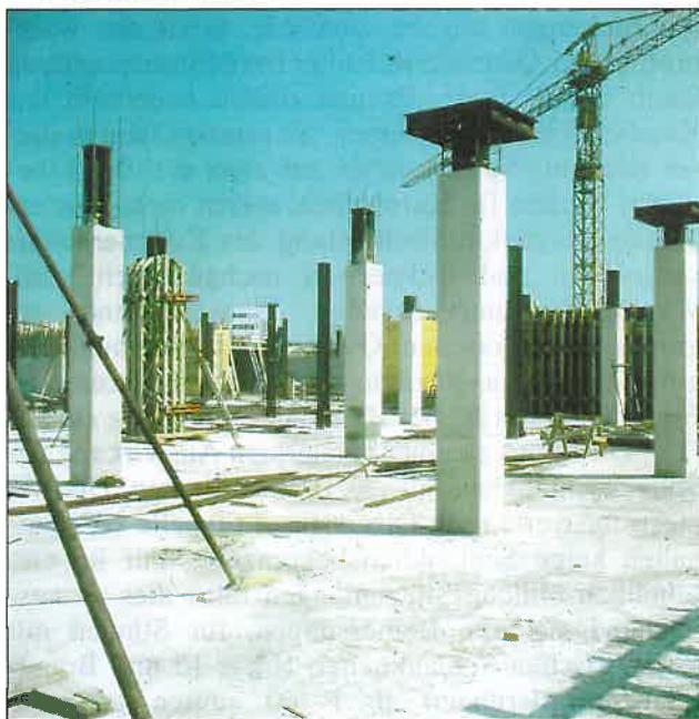
Abb. 20: I-Verbundstützen, in situ Herstellung
