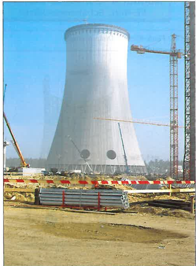
Abb. 27: Naturzugkühltürme Schwarze Pumpe Bauherr: Vereinigte Energiewerke AG, Berlin Bauunternehmung: E. Heitkamp GmbH, Herne
