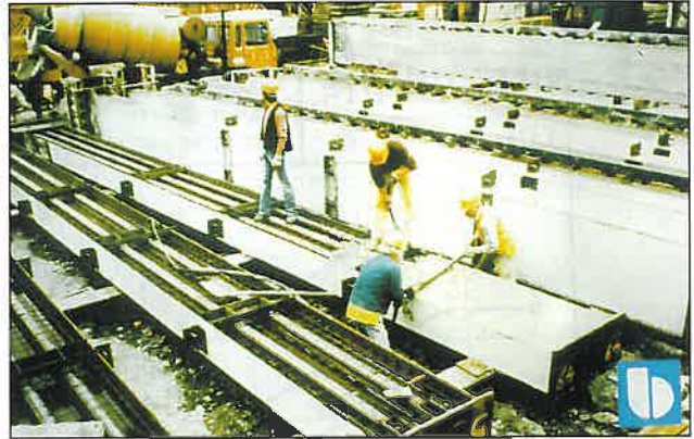
Abb. 22: I-Verbundstütze – Sonderquerschnitt (Kö-Galerie, Düsseldorf)
