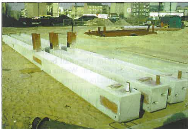
Abb. 19: I-Verbundstützen, Vorfertigung
