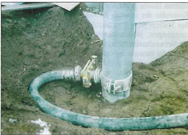
Abb. 14: Verpressen vorgefertigter und montierter Hohlprofilstützen mit Fließbeton
