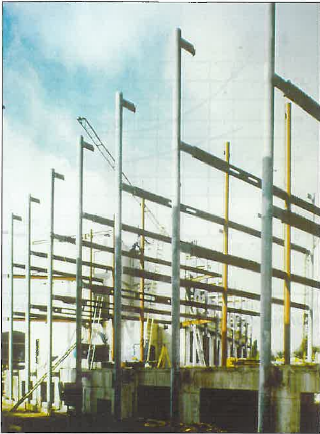
Abb. 13: 3- und 4-geschossige Hohlprofil-Verbundstützen als Durchlaufkonstruktion, vorgefertigt und ohne Betonverfüllung montiert (VdEh-Gebäude, Düsseldorf)
