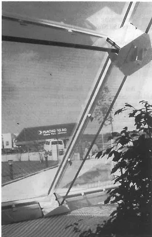
Abb. 4: Detail der verschraubten Glaskonstruktion
